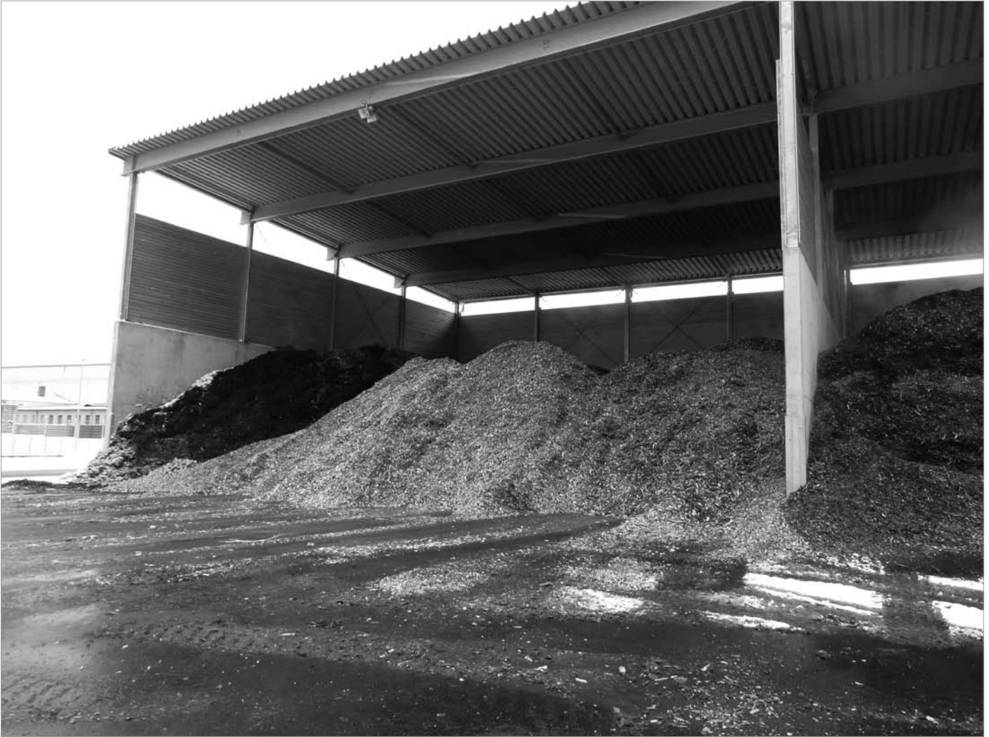
Lagerhalle für Hackschnitzel im Biomasse-Heizkraftwerk im Leiderer Hafen in Aschaffenburg
